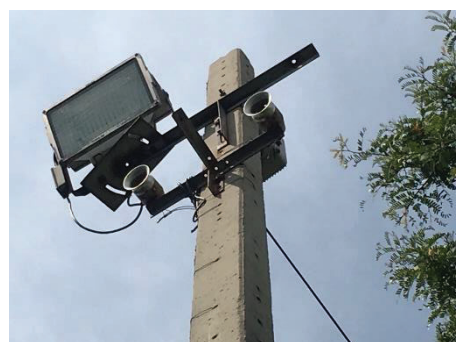
รูปที่ 2-3: หอสัญญาณเตือนการระเบิด
